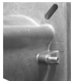
Штуцер для замера давления в камере сгорания
